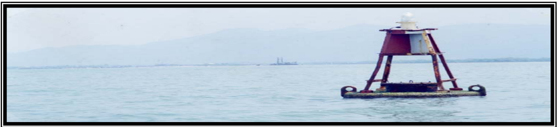
ภาพที่ ๒ ท่อนไฟฟ้ากรองของช่องทางเข้าคลองระนองเต่า
