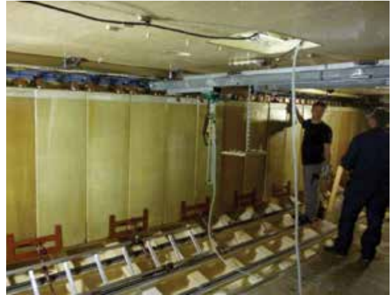
รูปที่ 28 การบรรจุเซลล์แบตเตอรี่โดยใช้เครน
