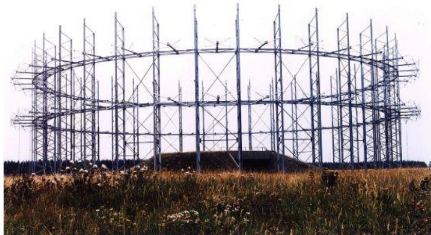
รูปที่ ๔ สายอากาศรับคลื่นวิทยุ HF ที่เมือง Bramstedtlund
