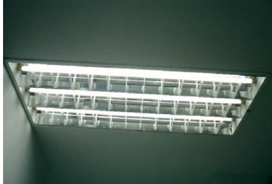
รูปที่ ๑ โคมไฟฟ้านิติด ๓ หลอด เมื่อเปิดใช้ทุกหลอด
