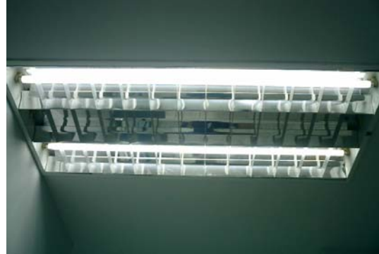
รูปที่ ๒ โคมไฟฟ้านิติด ๓ หลอด เมื่อเปิดใช้ไฟฟ้า ๒ หลอด
