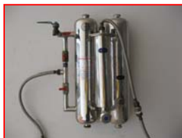
เครื่องกรองน้ำดื่มอาคาร ๑๐
