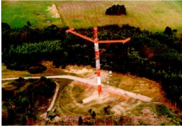
รูปที่ ๓ (ซ้าย) สายอากาศวิทยุ HF แบบหมุนได้ เมือง Marlow (ขวา) สายอากาศวิทยุ HF แบบคงที่ เมือง Neuharlingersiel
