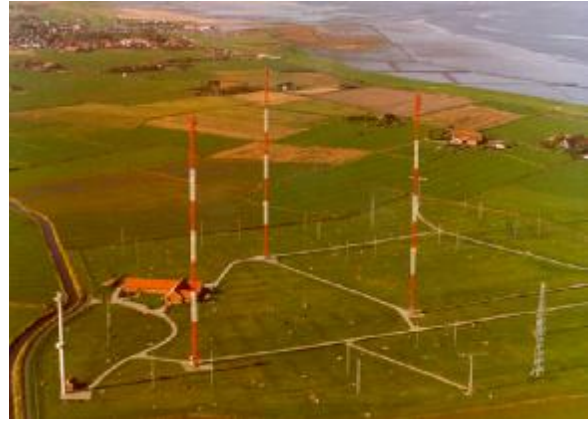
รูปที่ ๓ (ซ้าย) สายอากาศวิทยุ HF แบบหมุนได้ เมือง Marlow (ขวา) สายอากาศวิทยุ HF แบบคงที่ เมือง Neuharlingersiel
